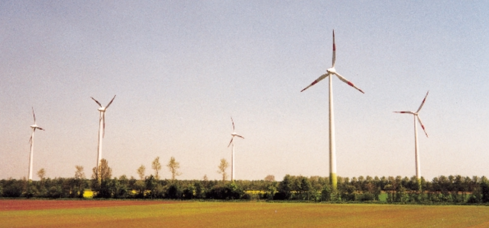
Windpark in Wilsum mit 10 Windkrafttürmen, Nabenhöhe 98 m
